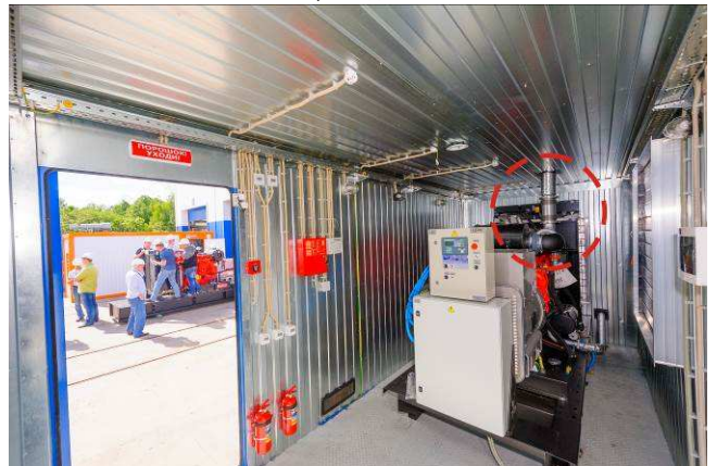
Тепло- и виброизолированная система газовыхлопа
