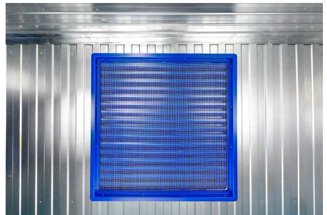
Изнутри проемы вентиляции защищены стальной сеткой, предотвращающей попадание посторонних предметов
