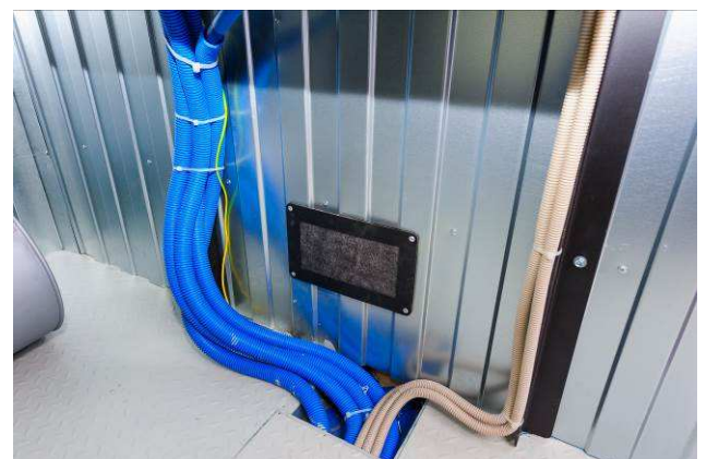
Уплотнительный резиновый клапан для ввода силовых кабелей
