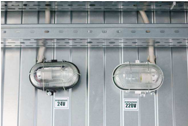
Система основного и резервного освещения
