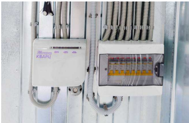
Система пожарной/охранной сигнализации на базе прибора «Кварц» и щит собственных нужд контейнера (ЩСН)
