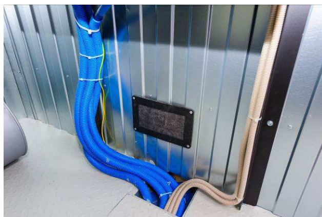
Уплотнительный резиновый клапан для ввода силовых кабелей
