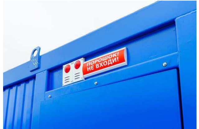
Внешнее световое табло «Порошок! Не входи», свето-звуковой пожарный оповещатель
